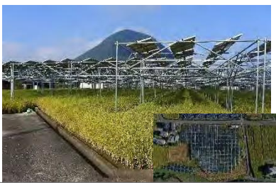
47畝(1座)、遮光率36%(可動式太陽能板)、栽培水稻
