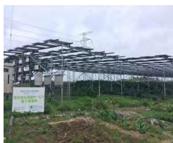
營農型太陽能發電設備
