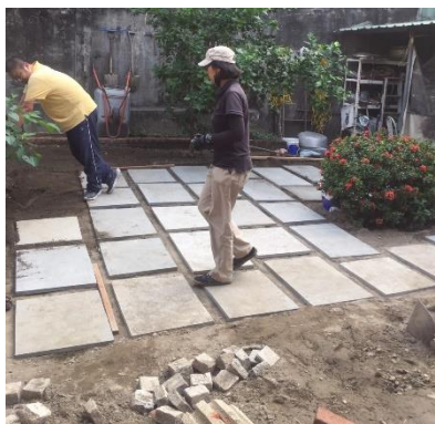
/確認石板擺放的位置/
