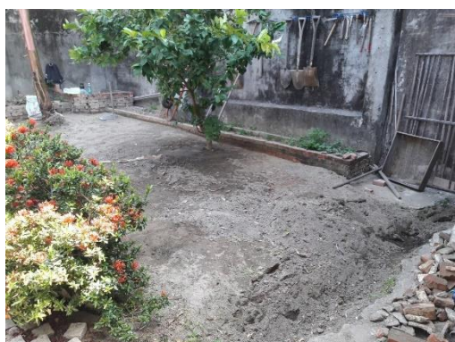
/為鋪設石板，將多餘的土壤移除/
