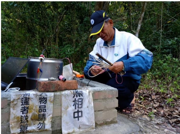
檢測監測水井地下水水位
