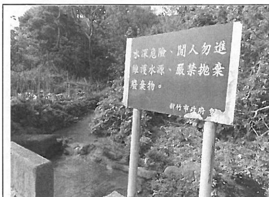
4/2 許育綸帶領聯盟媽媽勘查關埔計畫區家庭污水排放情形，上圖為匯入柯子湖溪之污水。
