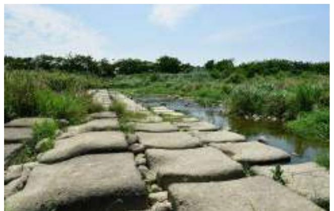
本流正橋下兩岸的水草岸以禾本科為主，動線長而豐盛(左圖)，基於保護橋墩，設有固床工消能(右圖)，使上方形成平緩潭區。
