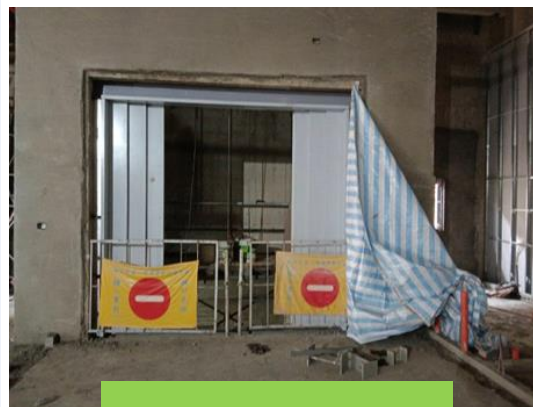
A電梯施作
