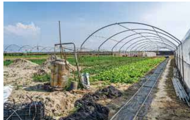
原本滿滿的溫室區域，目前僅剩零星幾座未傾倒。
