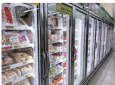
將冷藏、冷凍設備照明改為LED燈，提高照度、降低溫度，設備更為耐用。
