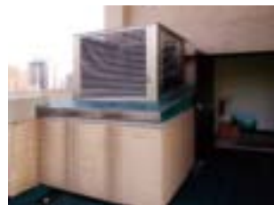
(改善後) 自然通風器完工後，改善了外面的風倒灌進浴室與住戶之間污濁的空氣互相干擾的問題。
