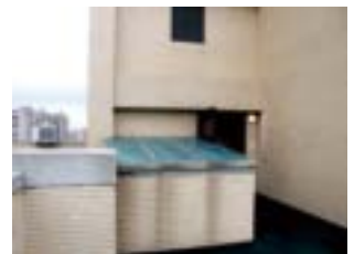
(改善前) 綠適居改善社區密閉狀態的採光天井前，僅有兩側裝設通風百葉。
