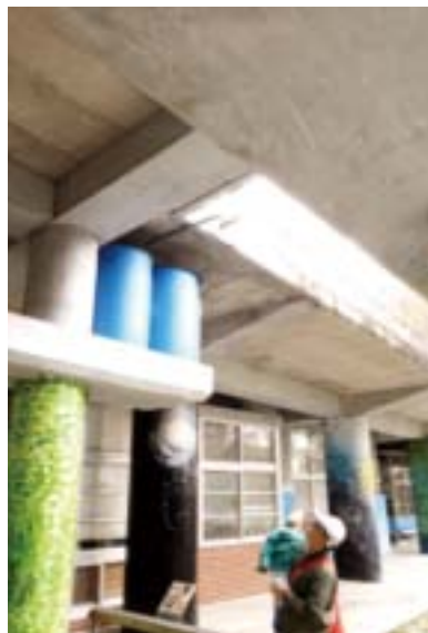
左 郭錫銘解釋設計概念：降雨初期收集到的雨水較污濁，因此必須操控水閥將初期收集的雨水排掉。
